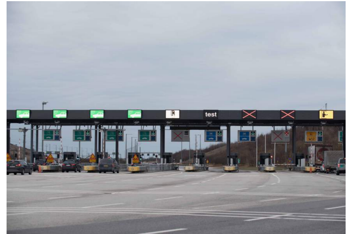
2017 byggdes betalstationen om med en teknologi som bland annat ger möjlighet att passera med hjälp av nummerplåtsavläsning.
