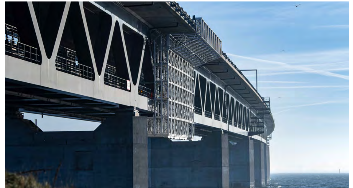
Den första av tre målningsplattformar är på plats.
