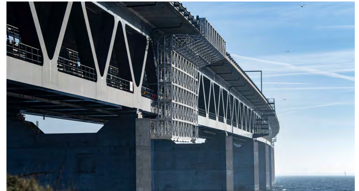
Den første af tre arbejdsplatforme er på plads.
