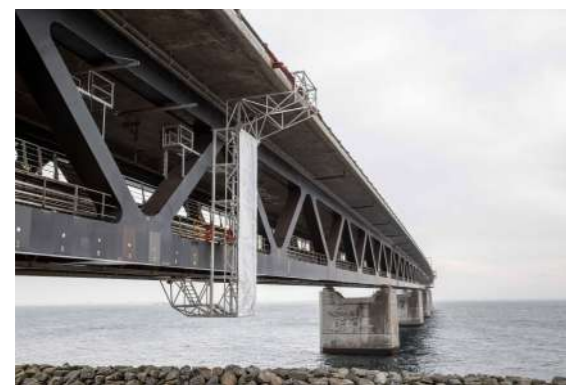
2019 påbörjas arbetet med att måla Øresundsbrons stålkonstruktion.
