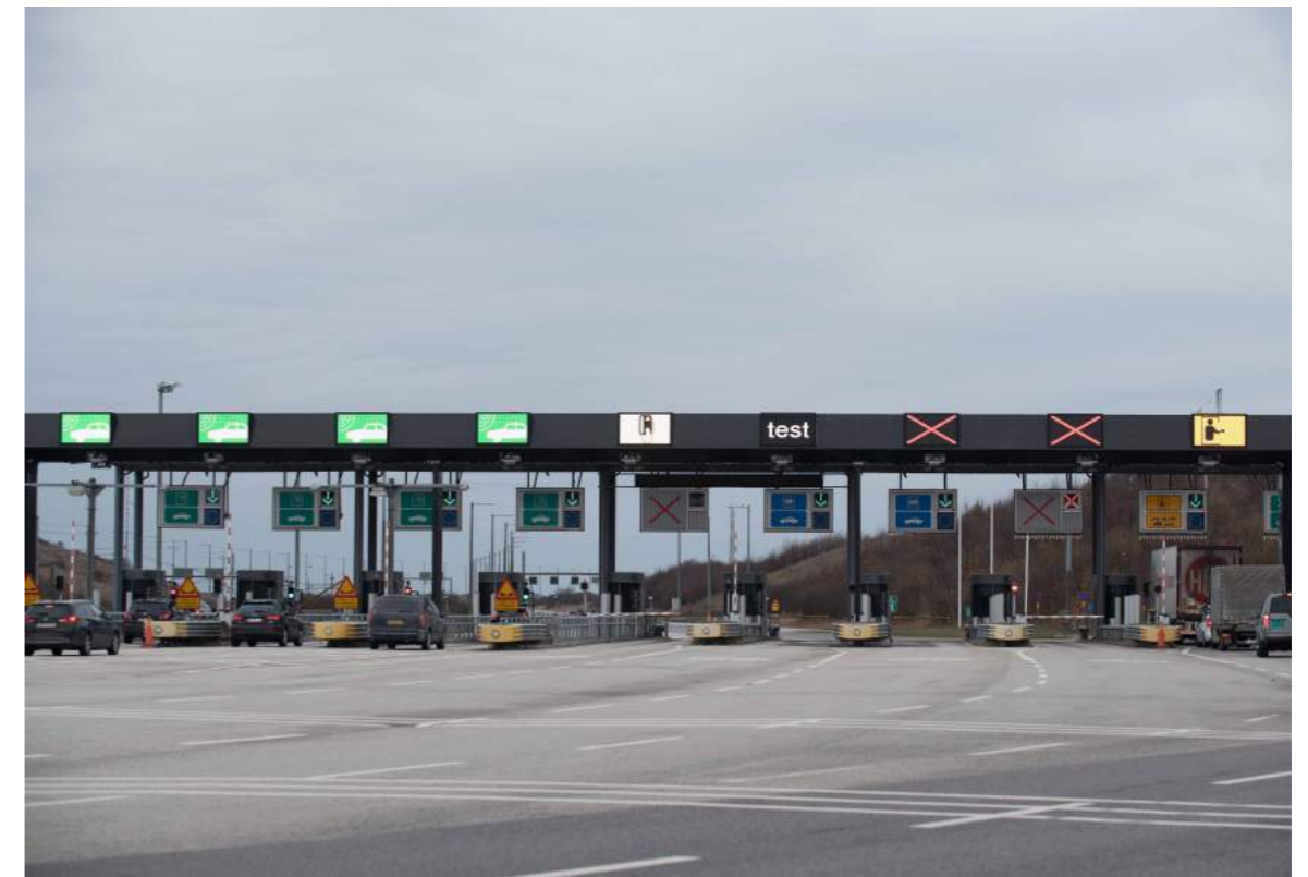
I 2017 blev betalingsanlægget ombygget med en teknologi med mulighed for blandt andet for passage af anlægget ved nummerplade aflæsning.
