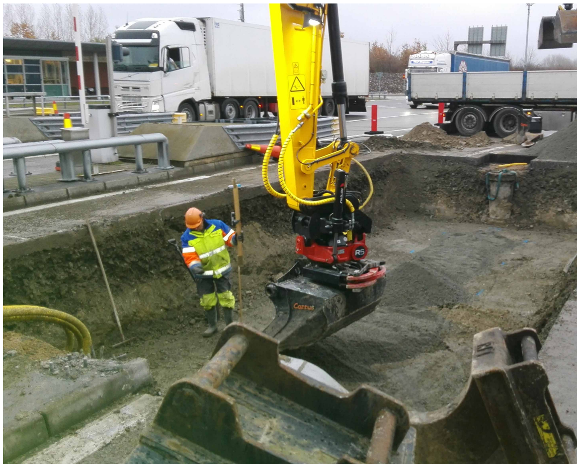
Ombygningen af betalingsanlægget forventes færdig i løbet af 2017.
